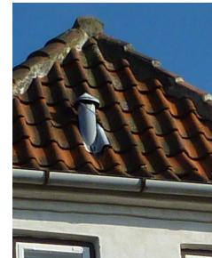
Udluftning i zink
