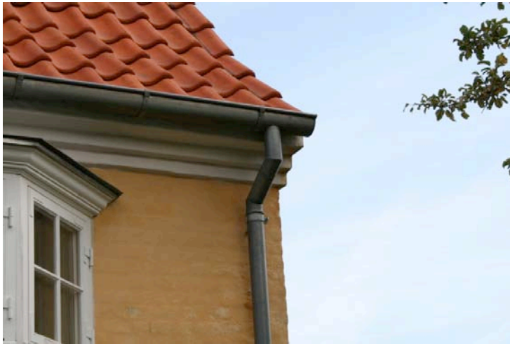
Udløb og nedløb fra tagrende udført med bajonetknæ.
