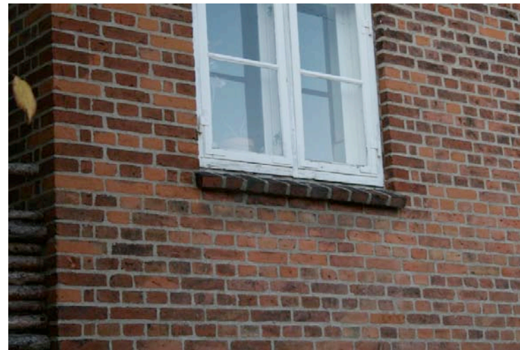
Muret sålbænk med sten på fladen.
