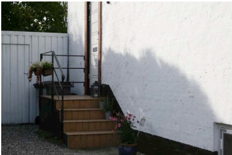
Støbt trappe med klinkebelægning.
